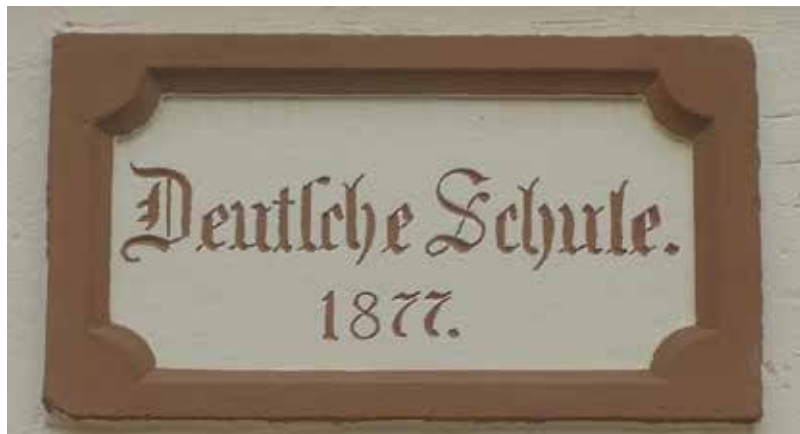
Die heutigen Besitzer des alten Schulhauses ließen die Inschrift nicht verkommen und pflegen sie stolz auch weiterhin, auch als ein weiteres Stockwerk errichtet wurde.
